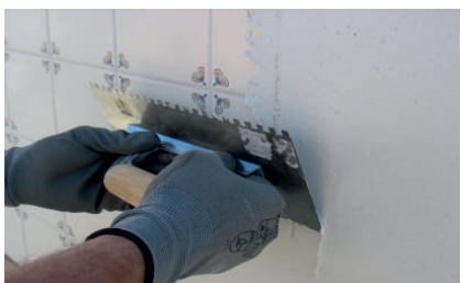
Barramento sobre cerâmicos antigos
