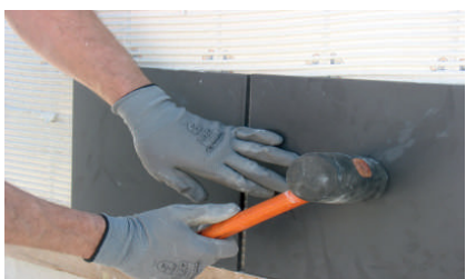
Assentamento com auxílio do maço de borracha
