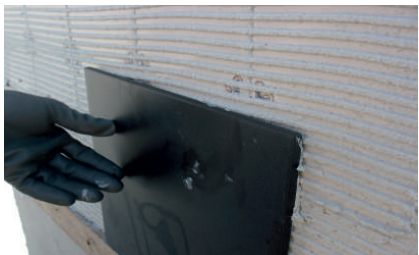
Colocação do cerâmico
