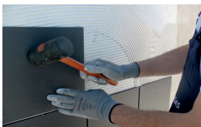
Assentamento com auxílio do maço de borracha
