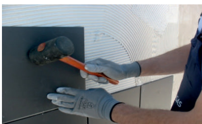
Assentamento com auxílio do maço de borracha
